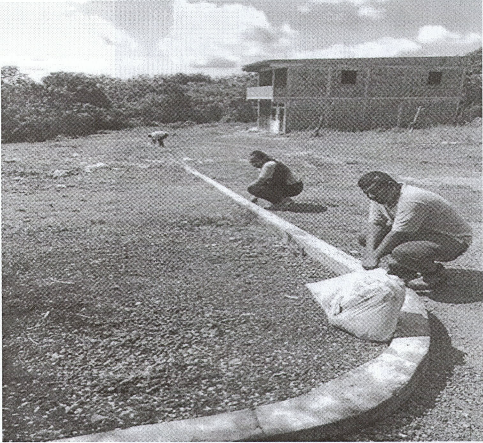
Ilustración 2 Corrección curvatura sardinel -Urbanización San Diego
